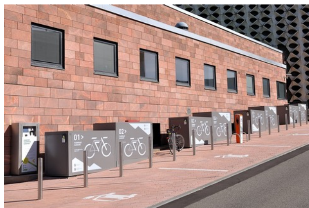
Fahrradgaragen an der Stadthalle Chemnitz
